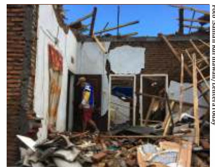
Sebuah rumah tampak hancur akibat gempa di Majang tengah, Dampit, Malang, Jawa Timur akibat gempa bumi akhir pekan kemarin.
