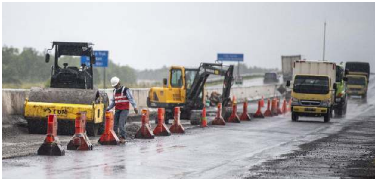
Perbaikan Jalan Tol Trans Sumatera ruas Terbanggi Besar-Pematang Panggang-Kayuagung menjelang Idul Fitri 2022. (foto-antara)
