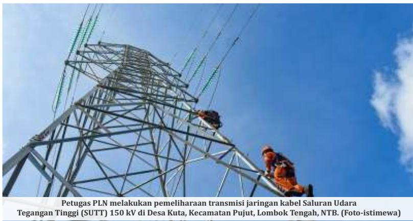
Petugas PLN melakukan pemeliharaan transmisi jaringan kabel Saluran Udara Tegangan Tinggi (SUTT) 150 kV di Desa Kuta, Kecamatan Pujut, Lombok Tengah, NTB. (Foto-istimewa)
