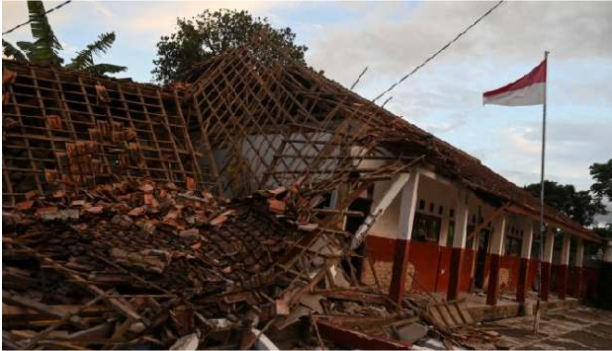
Kerusakan sekolah yang terjadi akibat gempa Cianjur (Istimewa)
