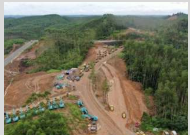
Pembangunan Ibu Kota Negara (IKN) Nusantara. (Dok.PUPR)
