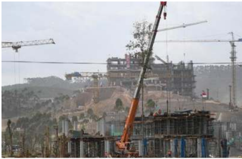
Pekerja menyelesaikan pembangunan di Kawasan Inti Pusat Pemerintahan (KIPP) Ibu Kota Negara (IKN) Nusantara, Penajam Paser Utara, Kalimantan Timur, Selasa, 22 Agustus 2023. Menurut data dari Satuan Tugas Pelaksanaan Pembangunan Infrastruktur IKN, proses konstruksi infrastruktur dasar IKN Tahap 1 sudah mencapai 38,1 persen dan seluruh kegiatannya masih terjaga dari sisi jadwal pelaksanaan (on schedule), dimana akan selesai pada 2024. ANTARA FOTO/M Risyah Hidayat
