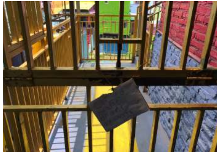
Tulisan "Closed, Bridge Under Repair" masing terpasang di depan pagar penutup menuju akses Jembatan Kaca di Kampung Tridi Kota Malang. (Santi/Lenteratoday)
