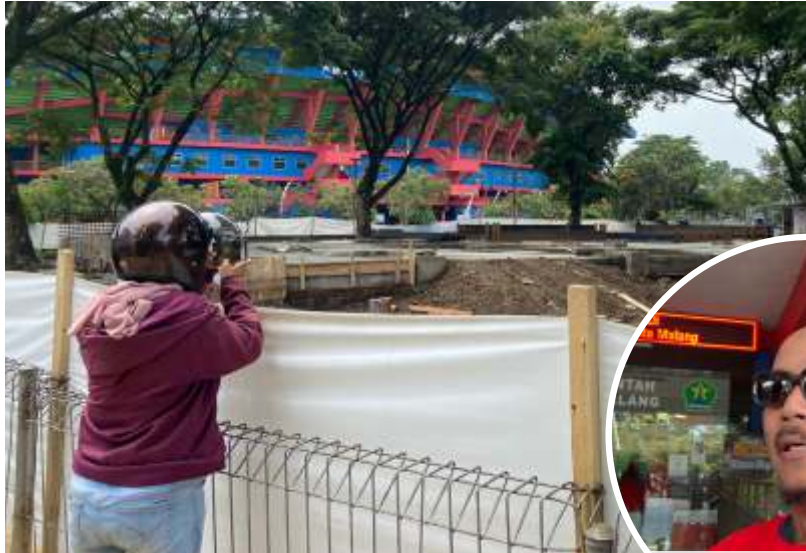
Proses pembangunan lahan parkir vertikal di kawasan Stadion Gajayana Kota Malang, Rabu (29/11/2023). (Santi/Lenteratoday)
