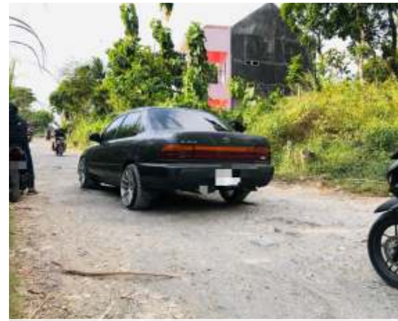
Kondisi jalan di salah satu wilayah Kecamatan Bantur Kabupaten Malang. (Dok. Istimewa)
