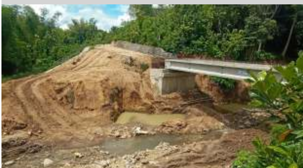
Kondisi saat ini proyek Jembatan Dawuhan di Kec Kademangan, Kab Blitar bantuan BNPB senilai Rp 7,4 miliar
