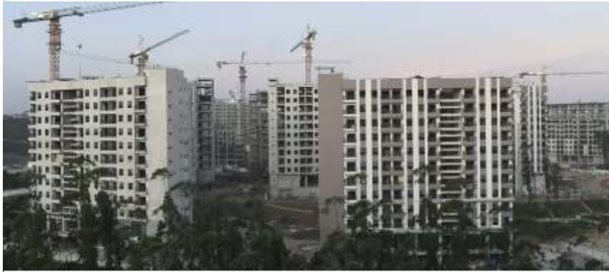
Pembangunan rusun hunian ASN di Ibu Kota Nusantara (IKN), Penajam Paser Utara, Kalimantan Timur, Jumat (13/9/2024). ANTARA
